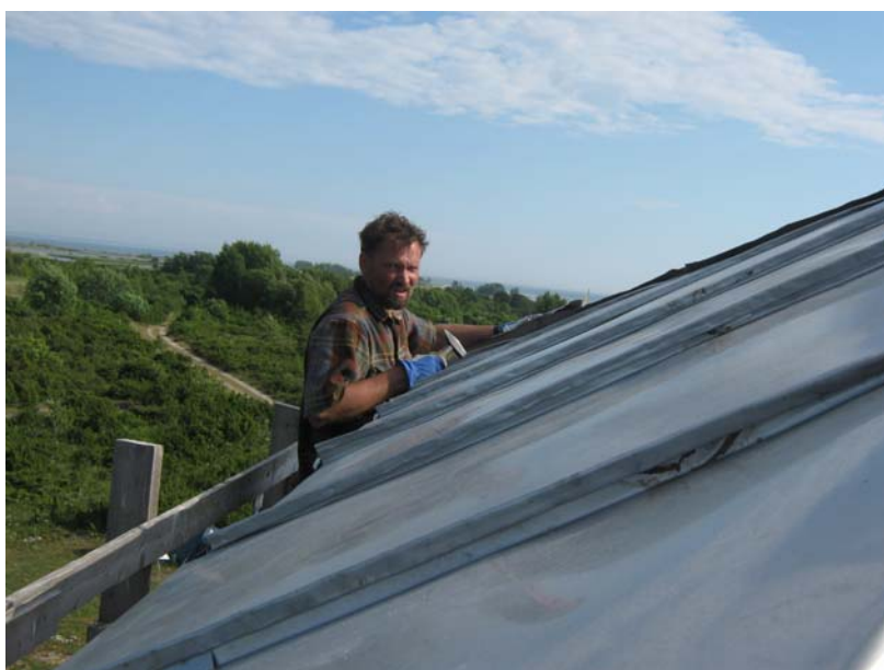
3.8. Katusekatteks paigaldati käsitsivaltsitud roostevaba terasplekk.
