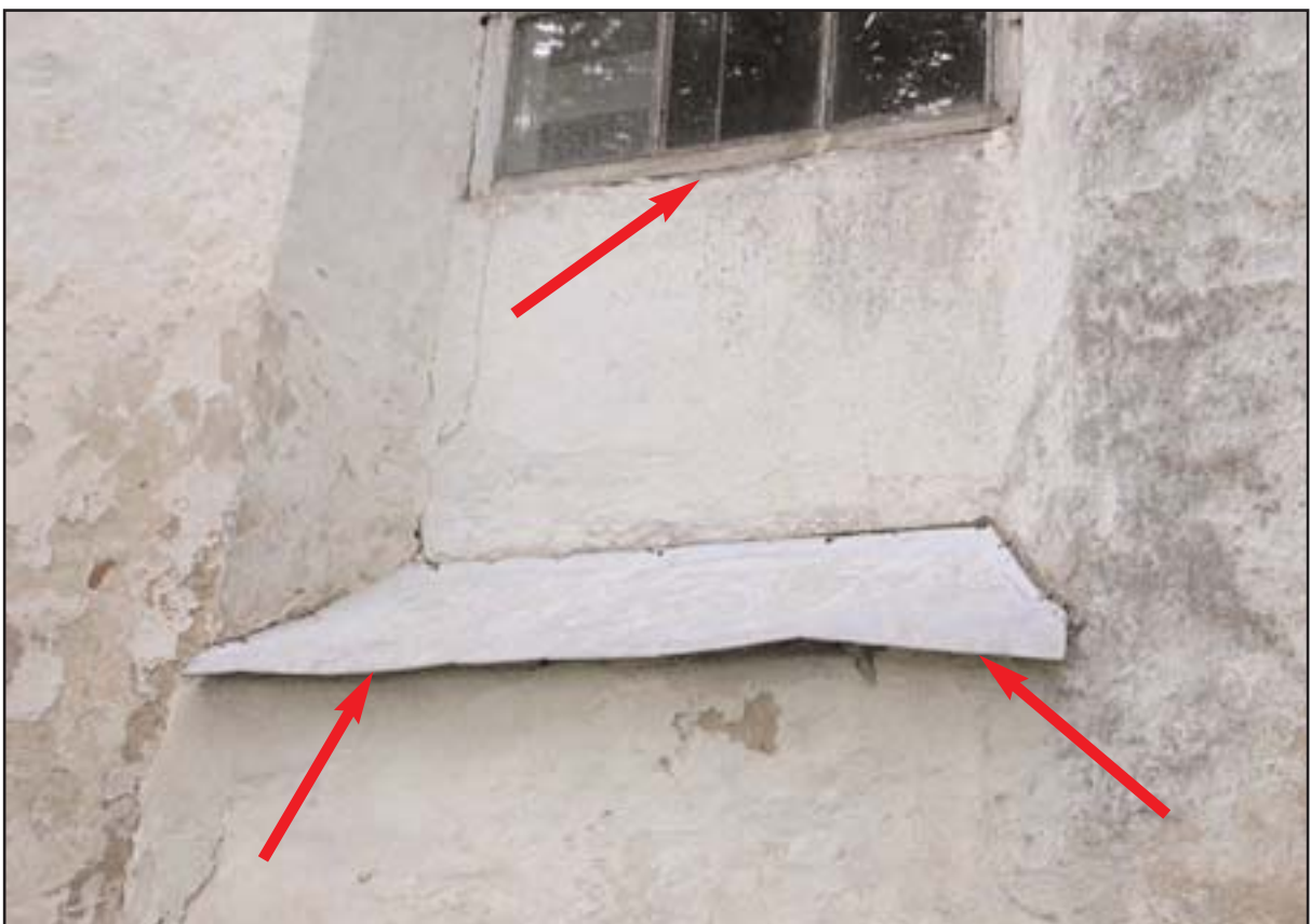
AKNANISHIDE PLEKID ON DEFORMEERUNUD JA SUUNAVAD VEE KONTSENTEERITULT SEINA PEALE. AKNA ALL PUUDUB VEEPLEKK JA KLAASIDELE SADAV VESI JOOKSEB SEINA PEALE.
